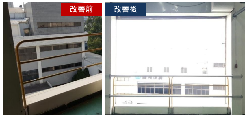
原護欄支撐及防護力較弱，加裝2支鋁擠型由二側牆面支撐
