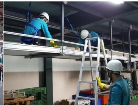
高空作業穿戴安全帽及繫上安全帶
